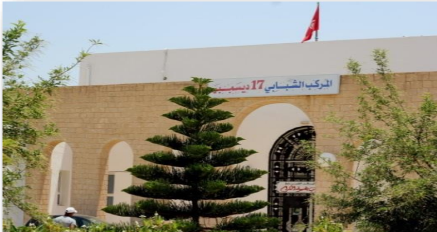
المركب الشبابي 17 ديسمبر سيدي بوزيد
